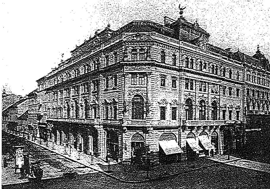
27. Az Országos Kaszinó Budapesten 1900-ban, nem sokkal az épület elkészülte után.
